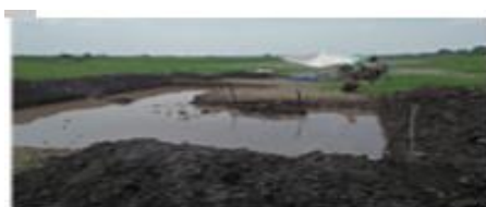
Gambar : Pembuatan Sumuran
