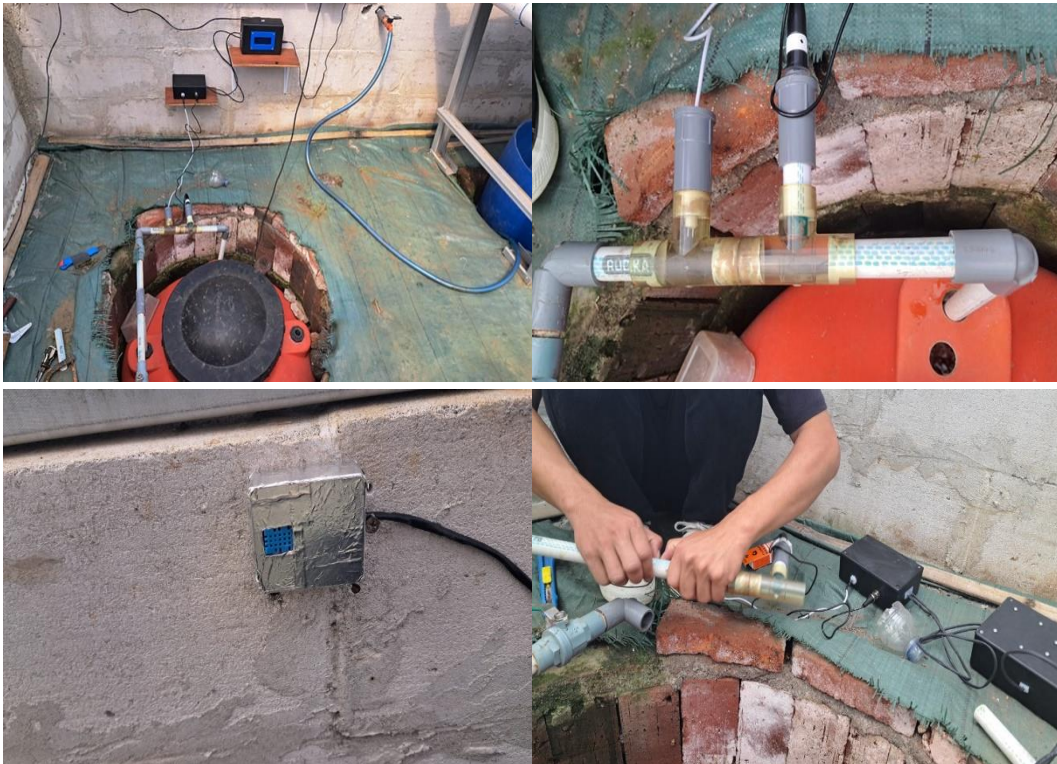
Gambar II. Pemasangan otomatisasi hidroponik sensor pH, TDS, EC, suhu, dan kelembapan
