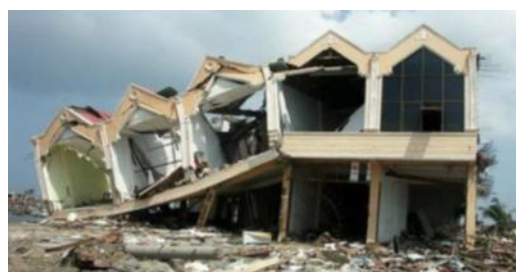
Gambar 2. Kerusakan Bangunan Akibat Gempa Lombok Tahun 2018 (Sumber: https://indopos.co.id/read/2018/08/11/146928/samijo-banten-aksi-peduli-gempa-lombok/ )
