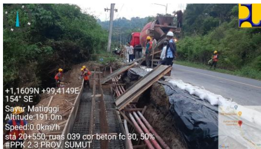
Gambar 1. Dinding penahan tanah tipe kantilever (Sumber : Pelaksanaan 2021)
