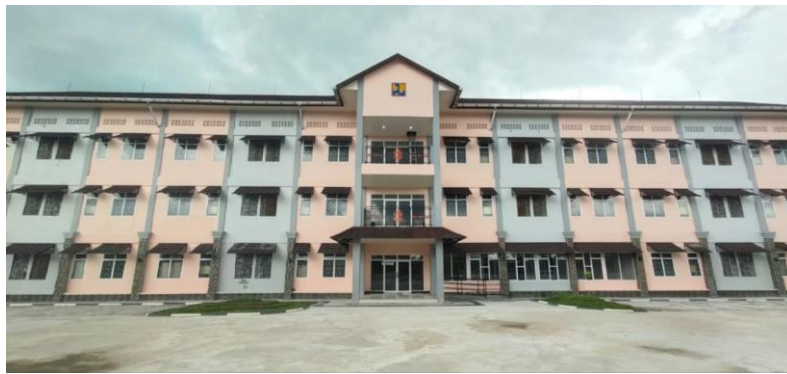
Gambar 3. Tampak depan Bangunan
