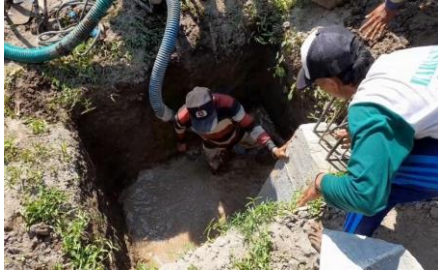
Gambar 5. Pemasangan mini-pile
