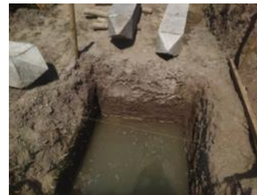
Gambar 1. Kondisi Tanah Di lapangan
