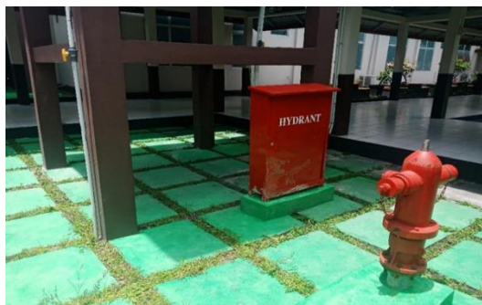
Gambar 4. Hidran Halaman (Sumber hasil dokumentasi survei)
