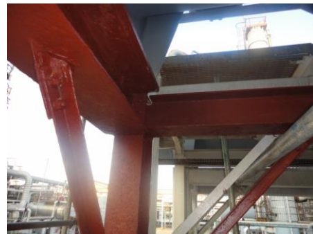
Gambar 3. Aplikasi primer coating dibawah Fire proofing struktur pipe rack
