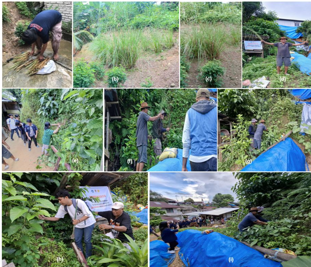
Gambar 5. Kegiatan prevensi longsor lereng dengan penanaman rumput vetiver . (a). Rumput vetiver , (b) dan (c) tanaman rumput vetiver yang telah tumbuh di bekas longsor lereng, (d) tanaman rumput vetiver yang siap untuk di tanam, (e) penanaman rumput vetiver oleh wakilan pemerintah Kelurahan Karang Panjang, (f) penanaman vetiver oleh Ketua PkM, (g) penanaman vetiver oleh Bpk. J. Maitimu (korban longsor), (h) penanaman vetiver oleh Ketua RT.03/RW/02, dan (i) selesai penanaman oleh Tim PkM dan mahasiswa geosains volunteer .
