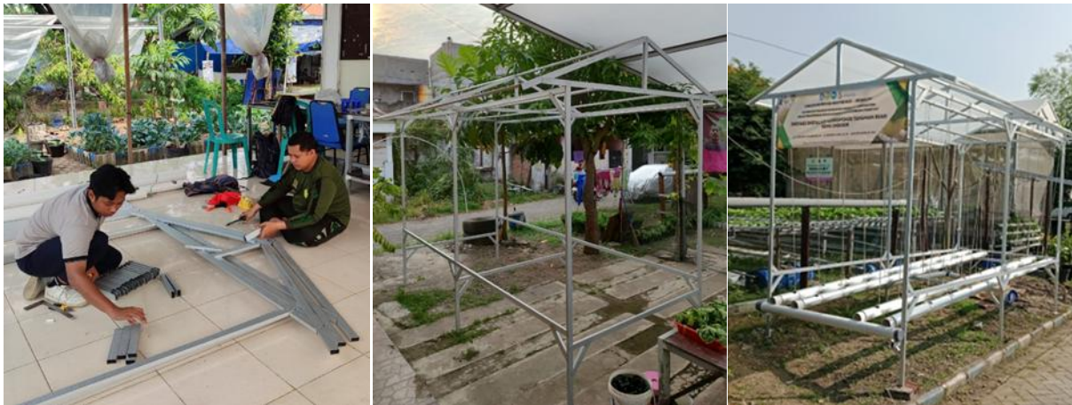
Gambar 3. Hasil konstruksi screenhouse dan instalasi hidroponik.
