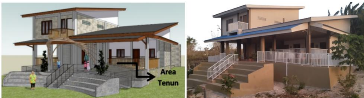
Gambar 1. Perbandingan rancangan awal Rumah Belajar “Ume Halan” (kiri) dan hasil pembangunan aktual (kanan) sebagai ruang pemberdayaan perempuan dan anak di Kampung Bonen (Dokumentasi Tim PKM Tahun 2024).
