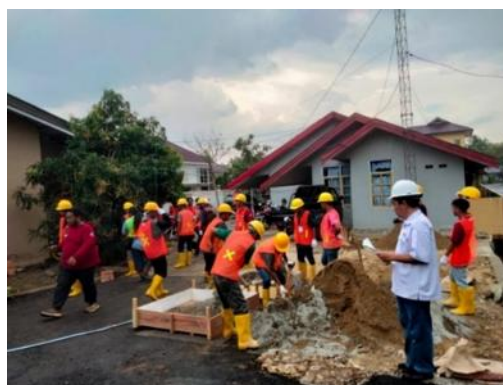
Gambar 3. Praktik Pemakaian APD Pada Pekerjaan Beton
