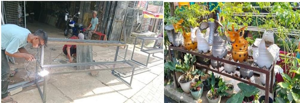
Gambar 3. Pembuatan custom made rak besi sebagai pendukung area hijau komunal.
