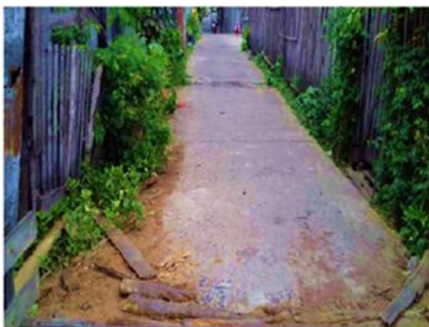
Gambar 3. Sebelum Pemasangan Drainase Tertutup
