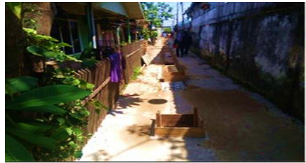
Gambar 4. Setelah Pemasangan Drainase Tertutup
