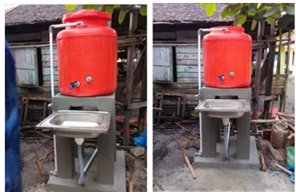
Gambar 10. Bak cuci tangan dengan Beton Campuran Limbah Rotan
