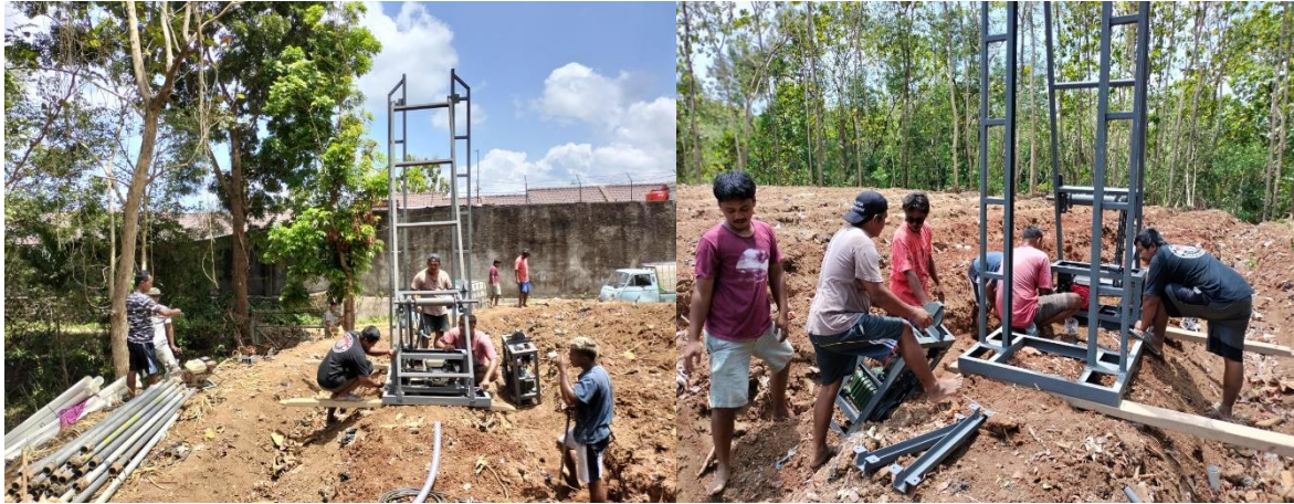
Gambar 6. Proses pembuatan sumur bor sedalam 60 m
