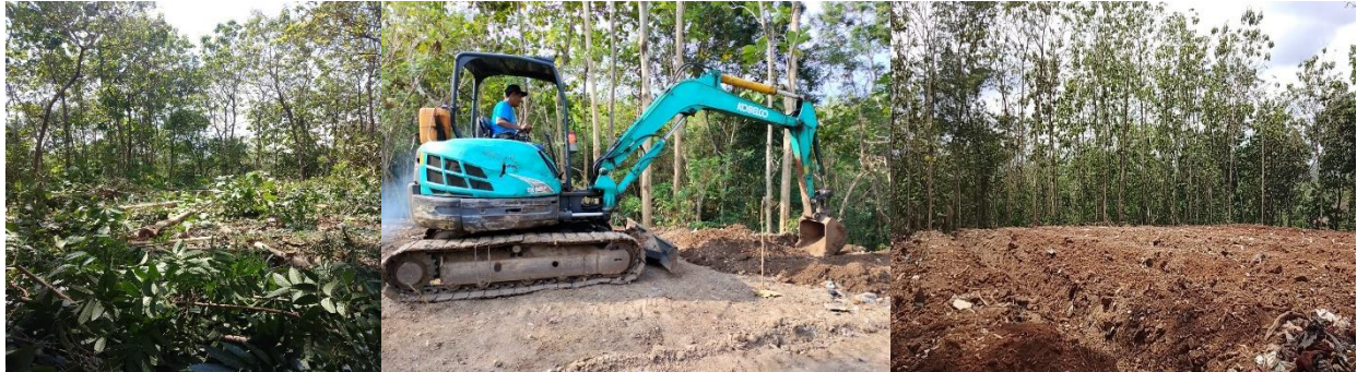
Gambar 4. Proses Land Clearing dan Penyiapan Lahan Tanam
