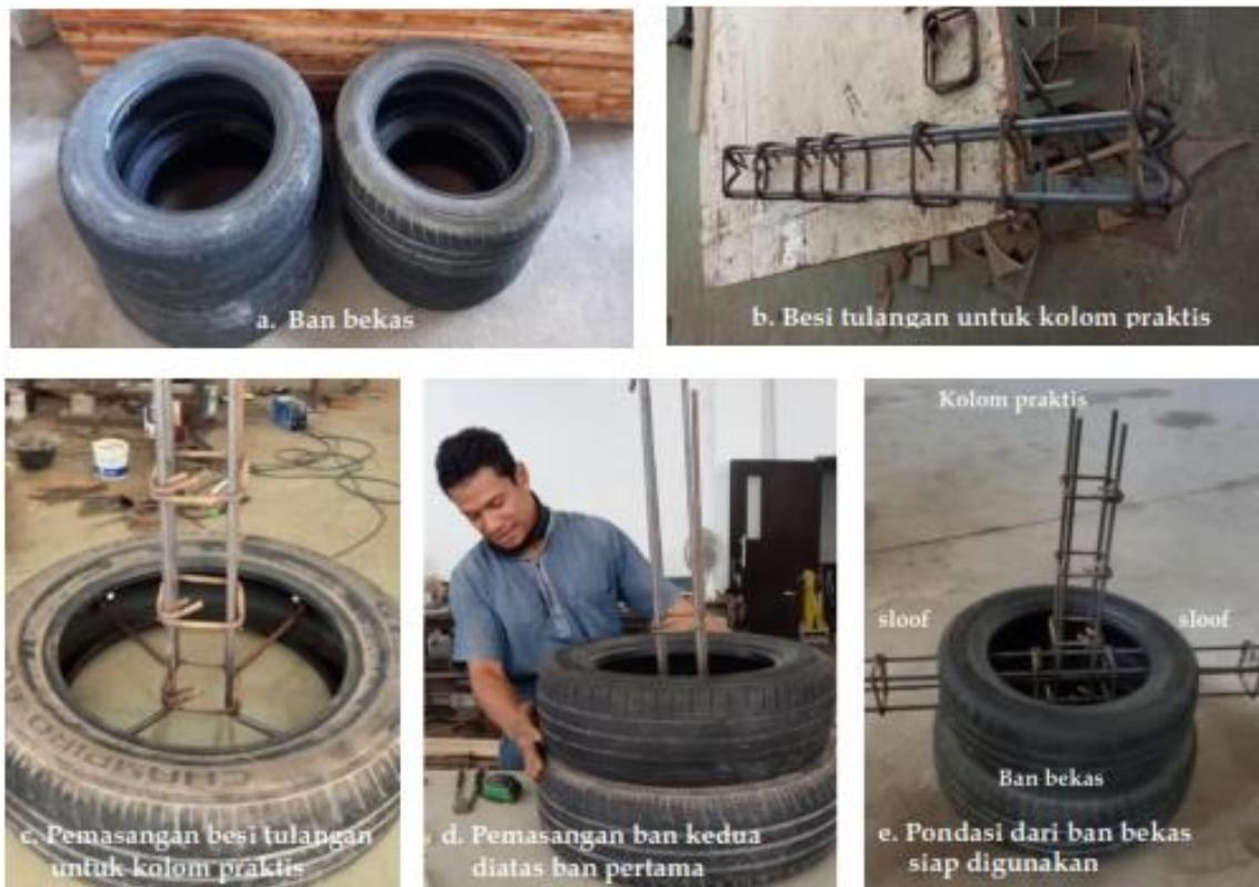
Gambar 2. Proses pembuatan pondasi setempat dari ban bekas
