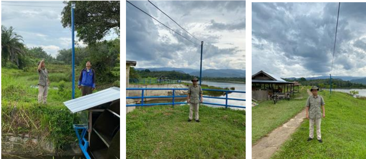
Gambar 6. Lokasi pemasangan tiang listrik.
