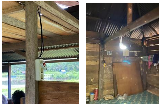
Gambar 7. Pemasangan stokontak dan lampu di rumah warga
