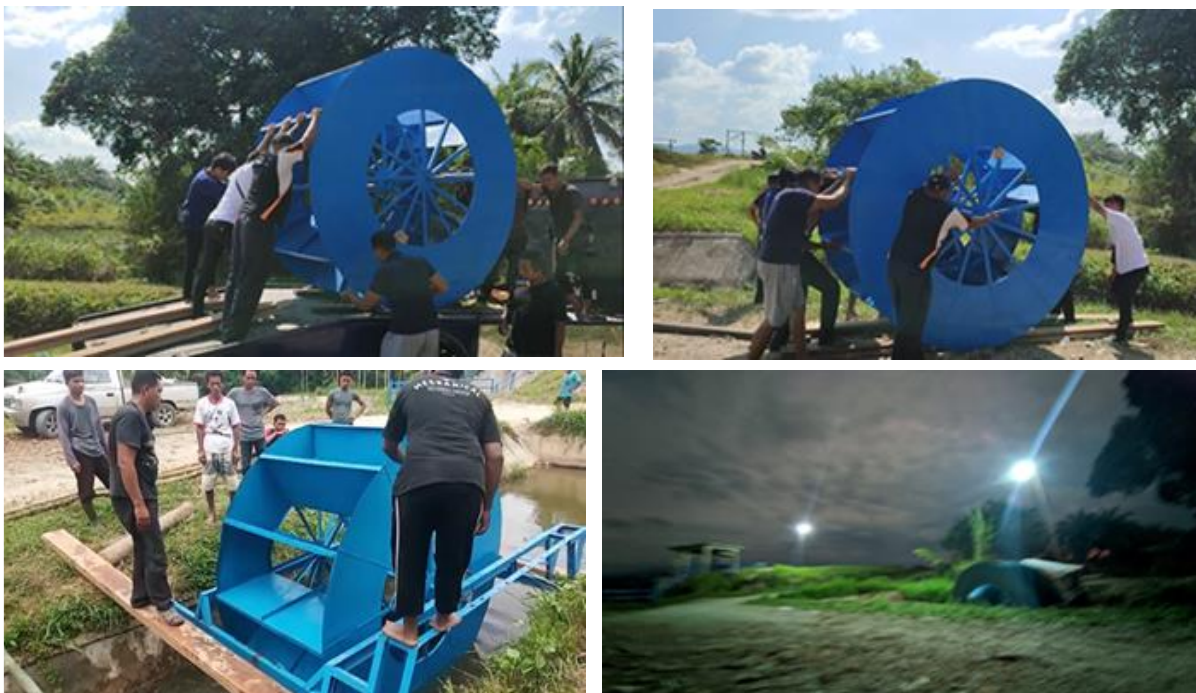
Gambar 4. Proses pemasangan pembangkit di lokasi Bendungan Menaming.
