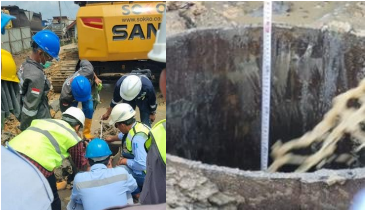
Gambar 6. Kontrol (cek) kondisi lubang bored pile.
