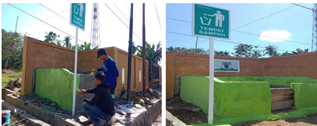
Gambar 6. Kondisi Setelah Pembenahan TPS RT 02
