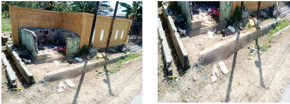
Gambar 4. Kondisi awal (Eksisting)/Kawasan permukiman kumuh RT 02
