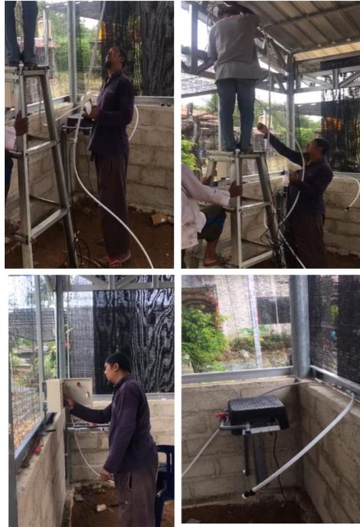
Gambar 9. Pemasangan penyiraman otomatis.
