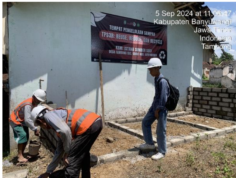
Gambar 8. Pekerjaan Pasangan Dinding.
