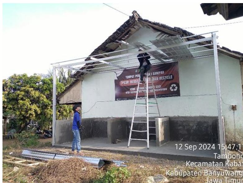
Gambar 9. Pekerjaan Atap Baja Ringan.
