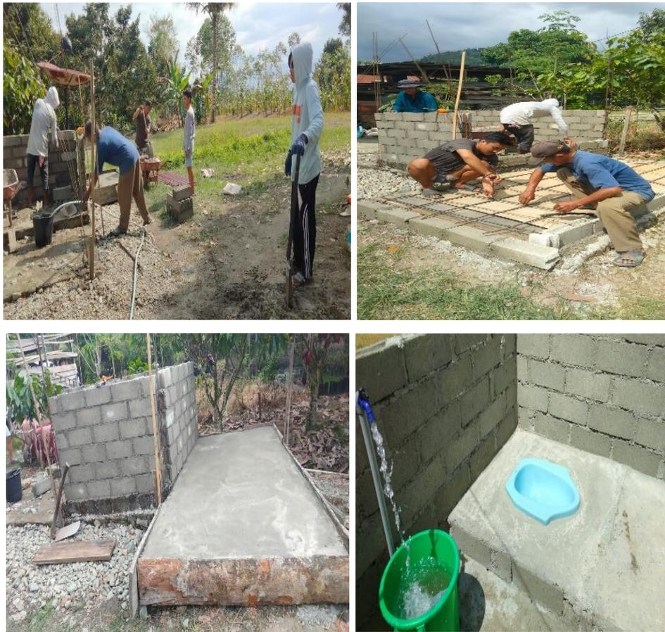
Gambar 4. Proses pembuatan jamban.
