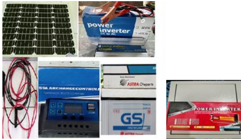
Gambar 2. Panel surya, charge controller dan battery pada UMKM Rumah Bali Hidroponik Kendari.
