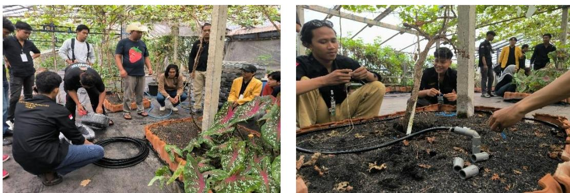
Gambar 2. Pelatihan Pemasangan dan Pengoperasian Saluran Fertigasi.
