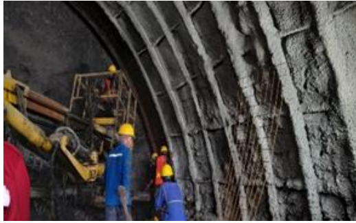
Gambar 4. Pemasangan Wiremesh dan Tierod.
