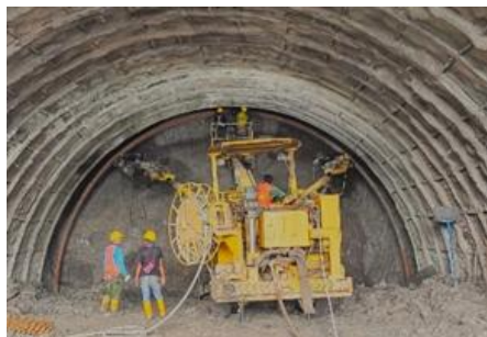
Gambar 3. Pemasangan Steel Rib.
