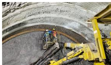
Gambar 6. Pengencangan Baut.
