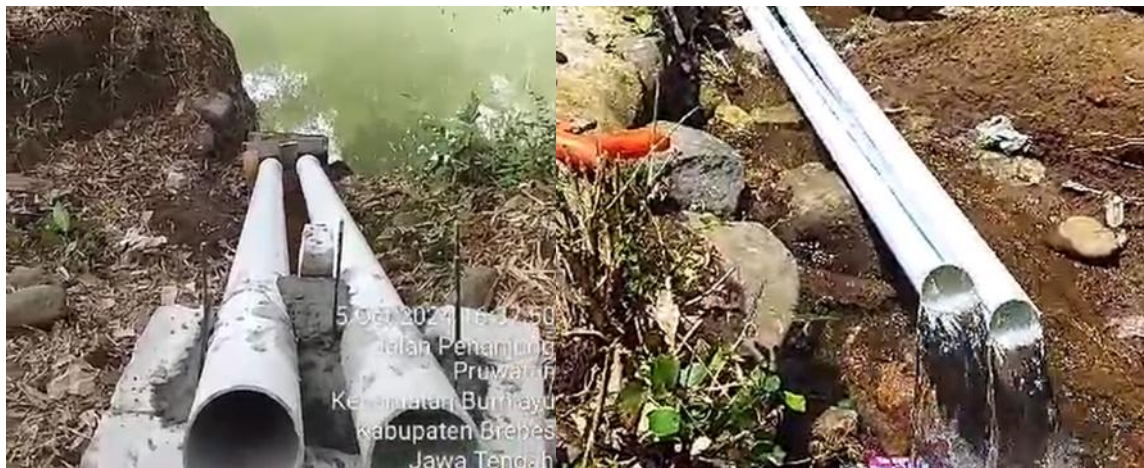
Gambar 4. Instalasi dual pompa submersible di Sungai Pemali.
