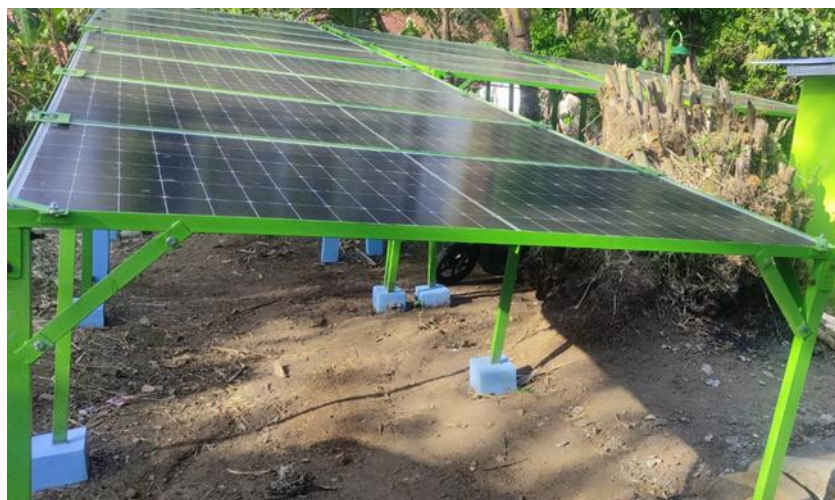
Gambar 2. Instalasi panel surya untuk pompa tenaga surya.
