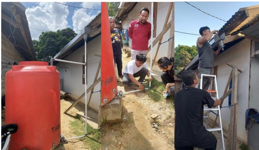
Gambar 3. Pembuatan Instalasi Pemanenan Air Hujan .
