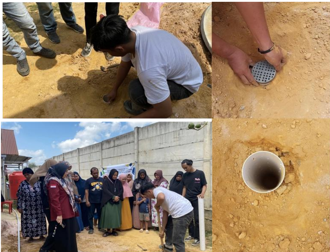
Gambar 4. Pelaksanaan pembuatan Lubang Resapan Biopori .
