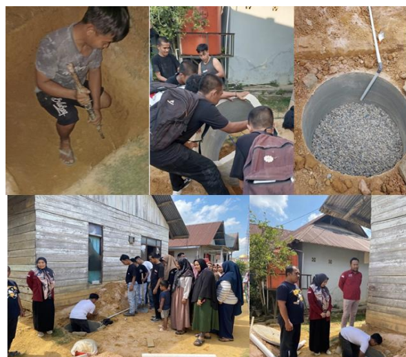
Gambar 2. Pelaksanaan Pembuatan Sumur Resapan.
