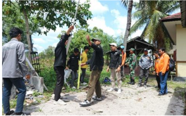
Gambar 4. Pemasangan Alat Data Logger.
