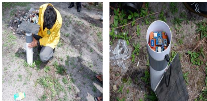
Gambar 10. Pemasangan alat dan penerapan teknologi sistem peringatan dini.
